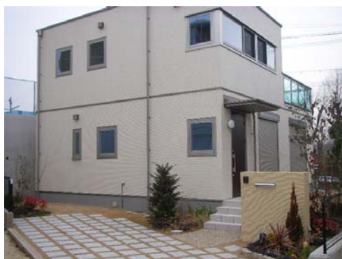
写真1： 防犯設計住宅
