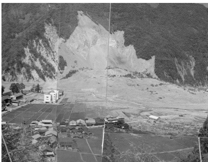
図序—2：大西山崩落直後の様子（1961 年）
